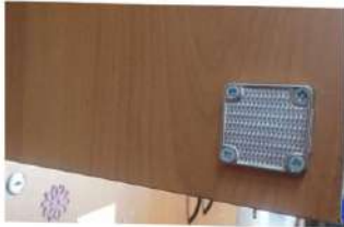
Instalación chapa... Sala de Profesores
